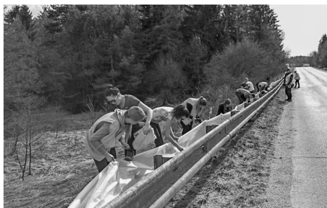
OBR. 3. Inštalácia dočasných zábran pri cestnej komunikácii na ochranu migrujúcich žiab.
